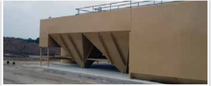
Planta rectangular construida en fabrica para flujos de hasta 100,000 GPD
